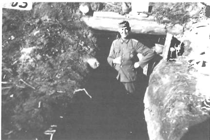
Bunker »Zum warmen Splitter« i Lutownja, overløjtnant, kompagnichef Pfeil, september 1941.
