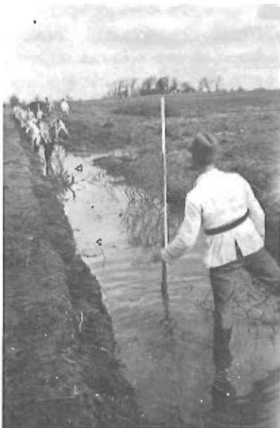
Nivellering af en afvandingsgrøft.
